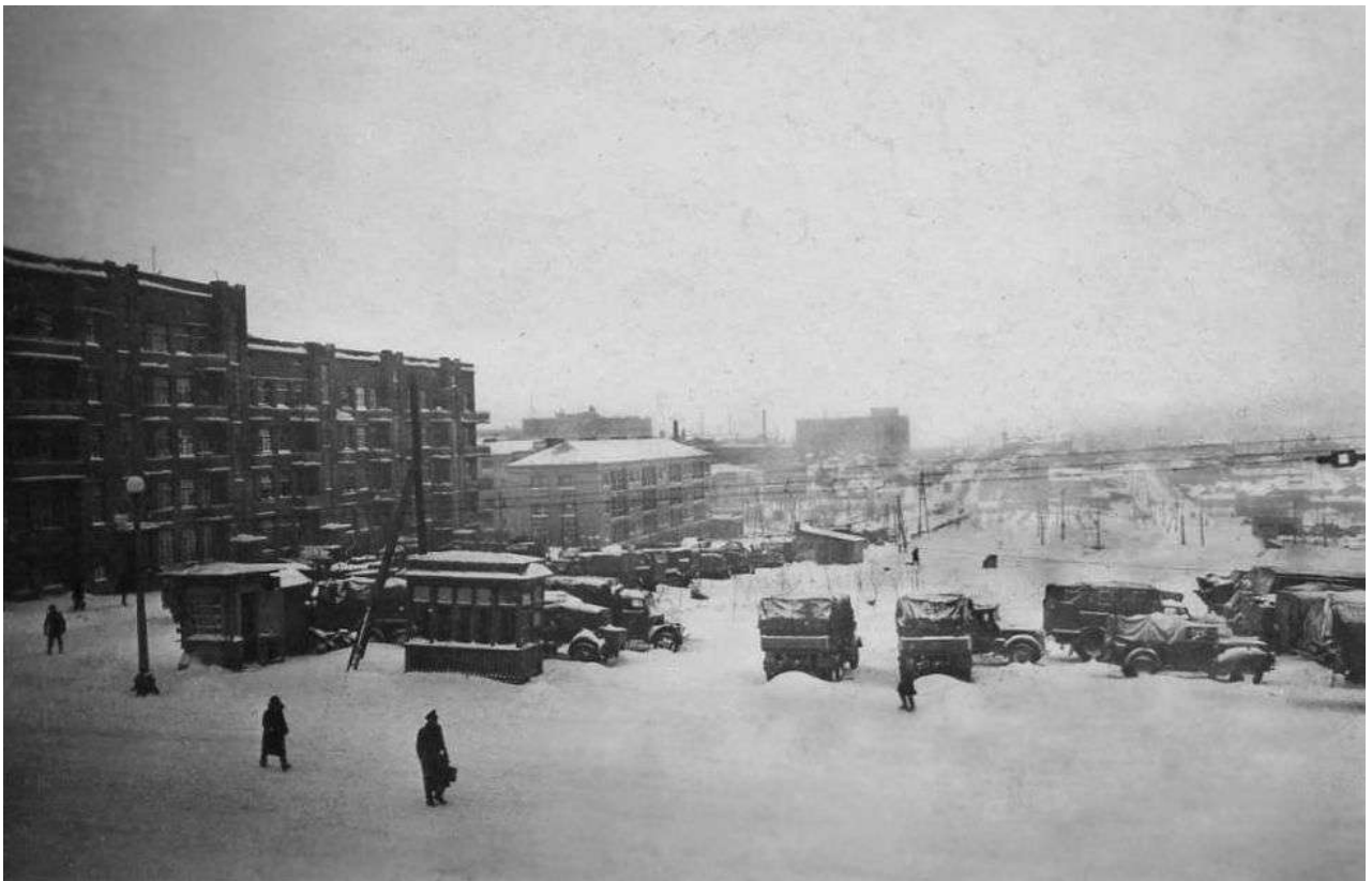
Насыпи путей товарной станции в сторону бани.
